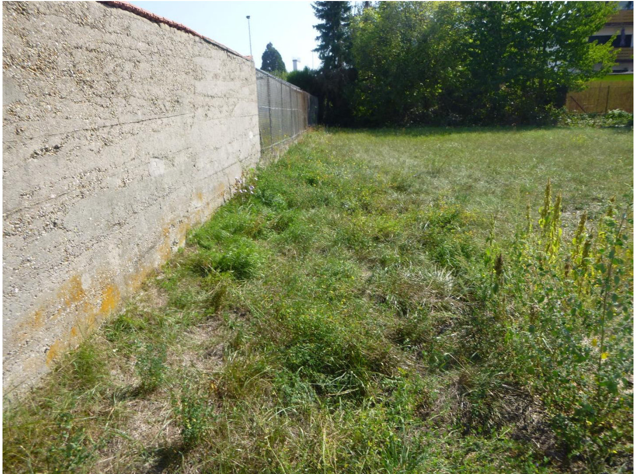
Abbildung 5: die vorhandene Mauer weist keine Spalten und Risse auf
